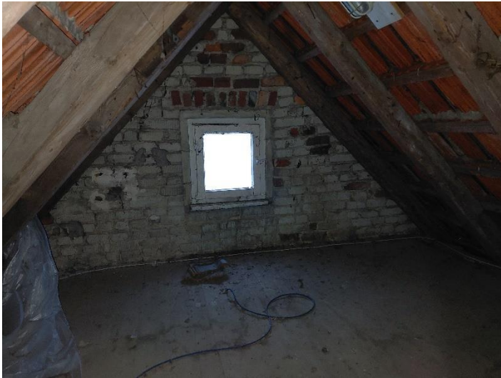
Abbildung 34: Bick nach Süden auf dem Dachboden.
