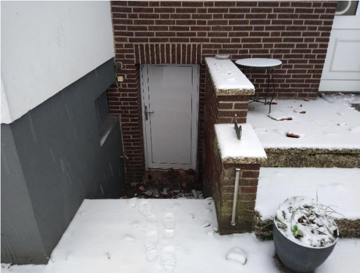
Abbildung 12: Zugang zum Keller über eine Außentreppe.
