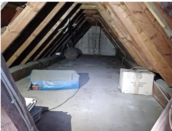
Abbildung 33: Dachboden über dem westlichen Anbau.
