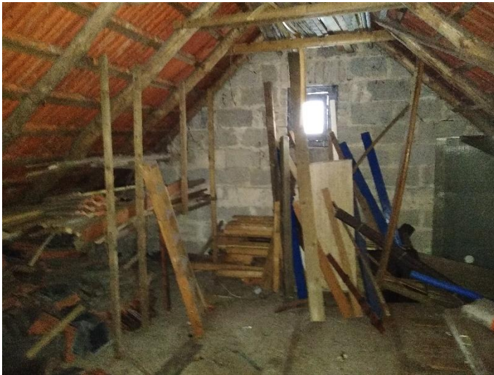
Abbildung 39: Dachboden der Garage.
