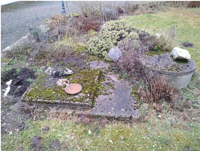
Abbildung 8: Trinkwasserbrunnen mit Wartungsschacht im Vorgarten mit Außenbeleuchtung nördlich des Wohnhauses.
