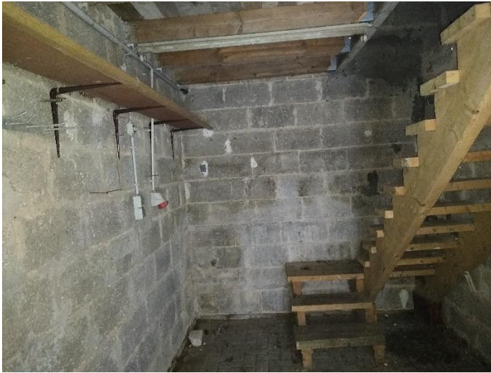
Abbildung 38: Treppe in der Garage. Die Wände sind aus Porenbeton.
