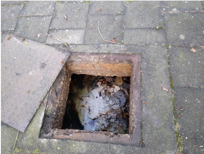
Abbildung 11: Blick in die Kleinkläranlage.
