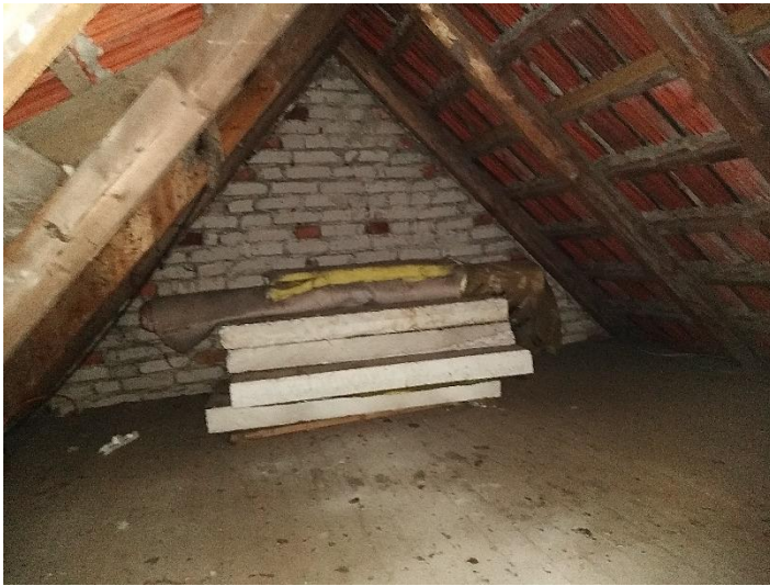
Abbildung 30: Nördlicher Teil des Dachbodens.
