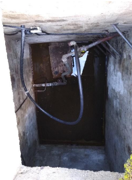
Abbildung 9: Blick in den Wartungsschacht.
