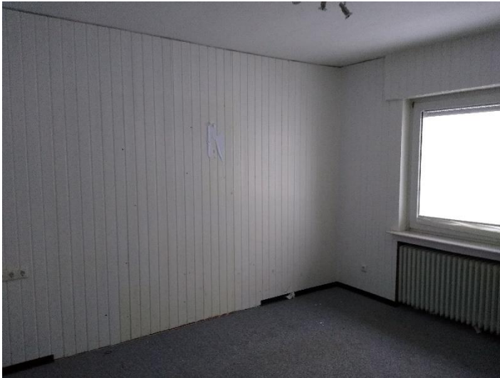
Abbildung 22: Schlafzimmer mit Wandvertäfelung aus Holz sowie zusätzlicher Innendämmung aus Polystyrol.
