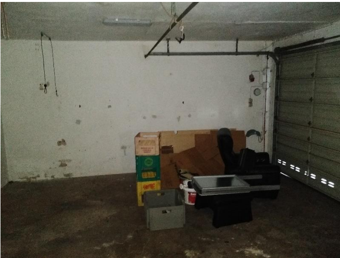
Abbildung 37: Innenansicht der Garage.
