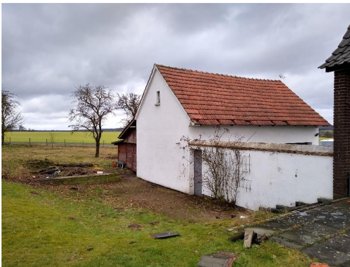
Abbildung 4: Blick aus dem Garten nach Westen auf die Rückseite der Garage sowie die Mauer zwischen Haus und Garage.
