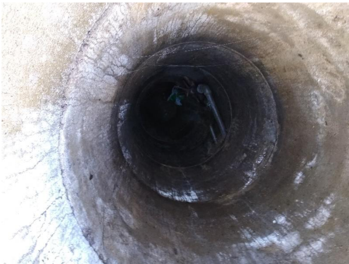
Abbildung 10: Blick in den Brunnenschacht.
